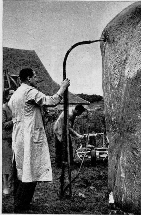
Le vide est fait sous la housse grâce à un embout qui est raccordé à la pompe à vide d'une machine à traire (photo de gauche). Au cours de l'opération qui dure 3 heures, la hauteur de la meule diminue de moitié.
