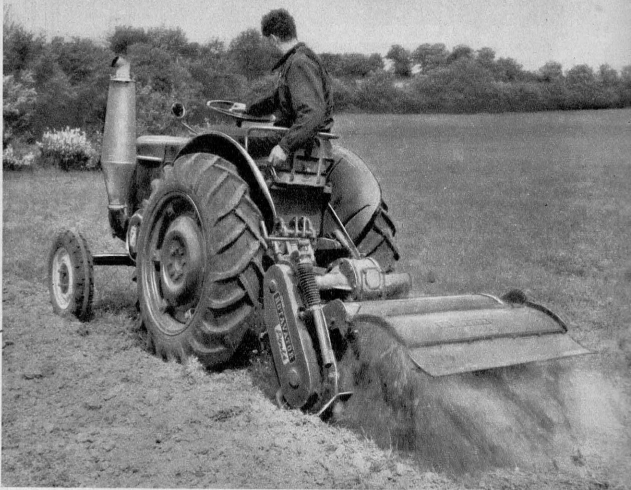
**ROTAVATOR** au travail. Cet instrument à lames entraîné par le moteur du tracteur, et tournant dans le sens de l'avancement de ce dernier, convient
