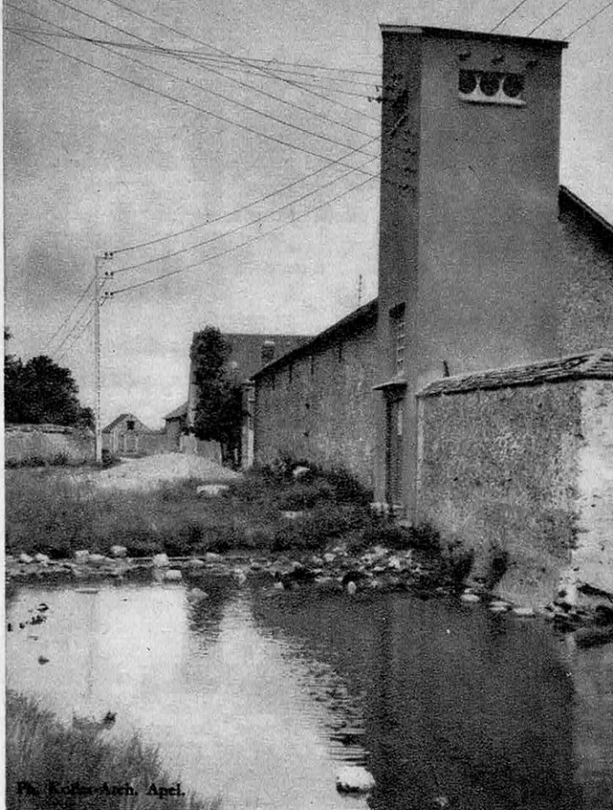
Le poste de transformation , d'architecture moderne, se dresse au milieu des vieilles pierres, tel le donjon du village au siècle de l'électricité.
