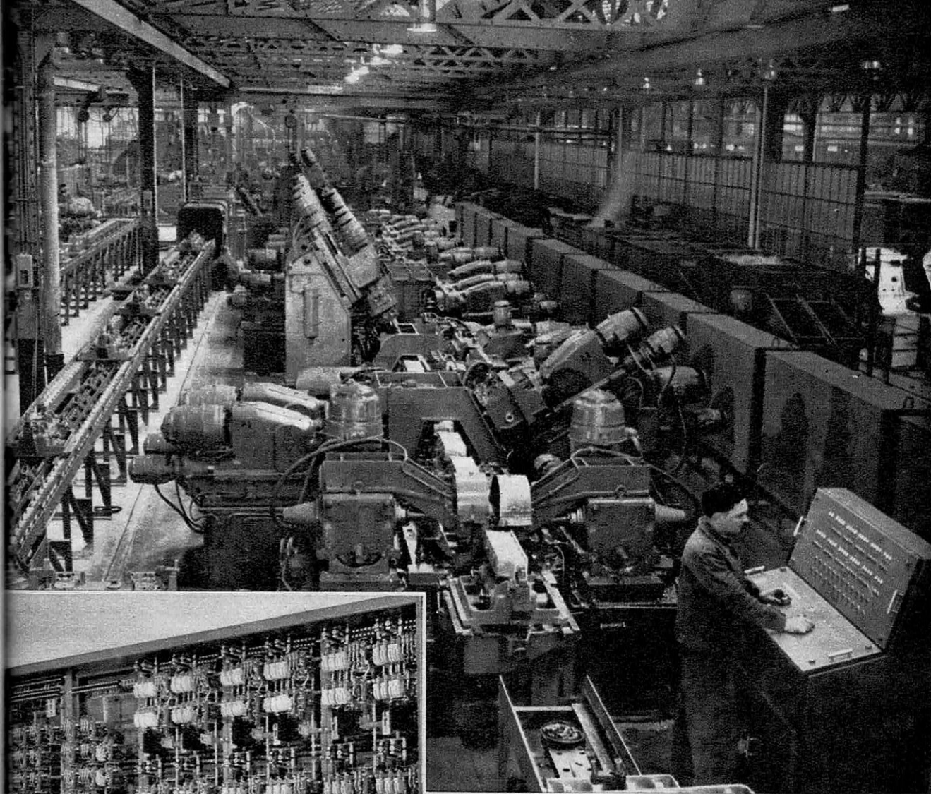
Cette machine transfert Renault effectue automatiquement diverses opérations sur les culasses de moteurs de Frégate. En bas, à gauche, une des armoires de la file de droite a été ouverte pour montrer une partie des contacteurs de commande.
