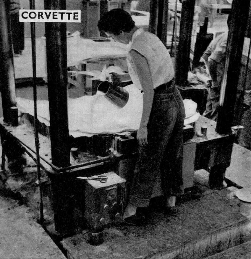
● Pour la confection du capot, l'opératrice dispose les couches successives de matelas de fibre de verre sur un moule mâle, et y répartit la résine.
