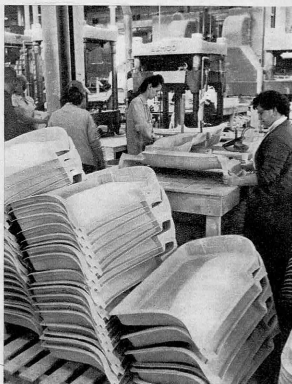
● Les opérations de finissage sont très réduites : ébarbage de la fibre, passage des bords aigus au jet de sable.
