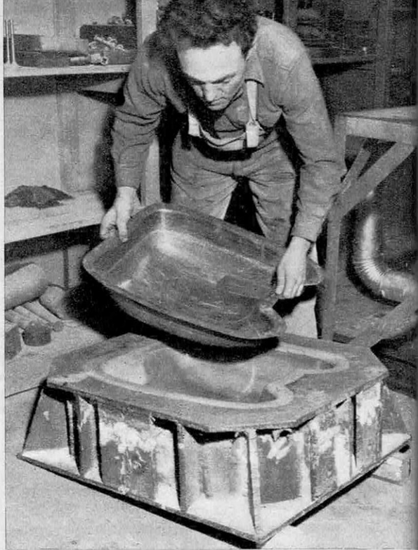
5 Une fausse pièce ayant l'épaisseur exacte des pièces qu'on devra emboutir est disposée dans la matrice.
