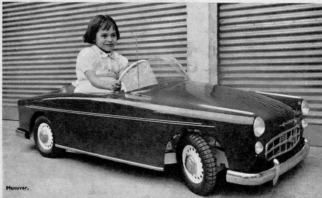
LA CARROSSERIE DE CETTE VOITURE EST EN RÉSINE POLYESTER ET FIBRE DE VERRE.
