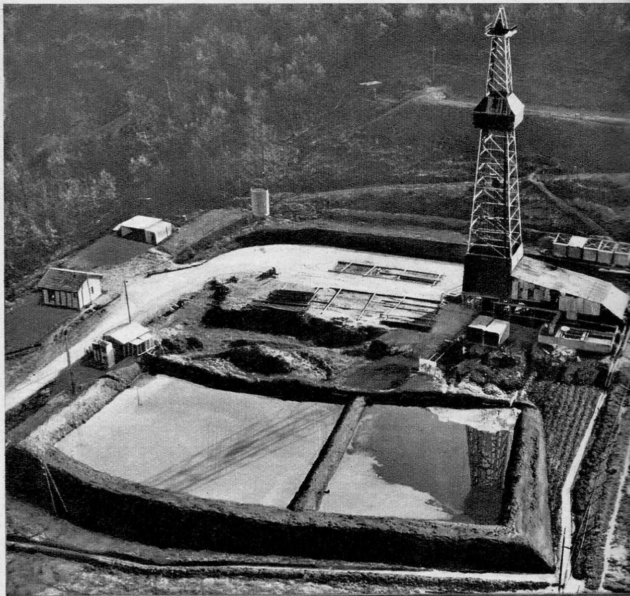
UNE SONDE ET SON BASSIN DE BOUE SUR LE CHANTIER DE SAINT-MARCET
