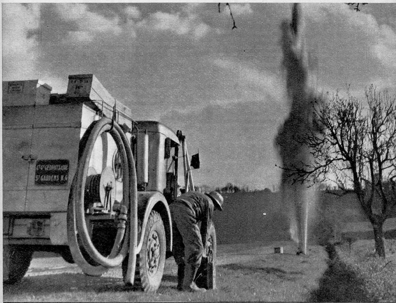
LE TIR D'UNE CHARGE D'EXPLOSIF LORS D'UNE PROSPECTION SISMIQUE.
