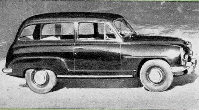
LA SIMCA 9 COMMERCIALE , voiture mixte, est, sur le plan mécanique, semblable à l'« Aronde », seul le rapport du pont est différent (8×43 au lieu de 9×43). Charge utile de 500 kg. Vitesse maximum 110 km/h.
