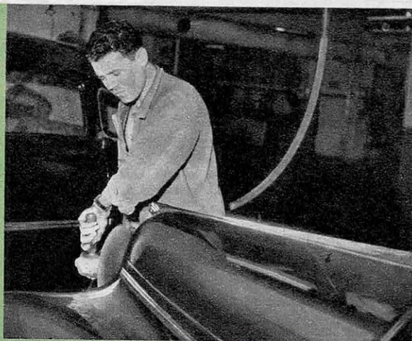
● L'émail de la carrosserie et les chromes sont enduits d'un produit spécial, puis le ponçage des grandes surfaces s'effectue à l'aide d'un tampon circulaire facilement maniable tournant à très grande vitesse.
