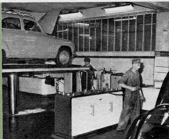
● Plusieurs ponts de graissage sont disposés côte à côte. Remarquer l'éclairage fluorescent « lumière du jour » qui donne sous tous les angles une bonne visibilité et permet de travailler jour et nuit sans fatigue.
