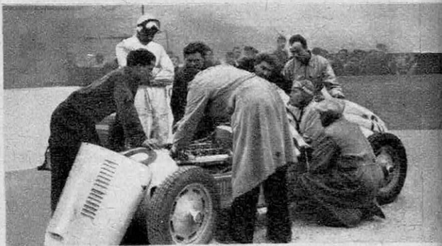
La voiture allemande de formule 2 du pilote Von Stuck, est une 2000 cm 3 AFM, 8 cyl. en V de 180 ch.
