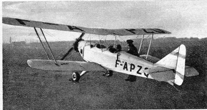
SCANOR « COLIBRI » (France), biplace capable de voler en toute sécurité avec un moteur de 45 ch; vit. 140 km/h. Décollage 50 m. Consomme 9 l/100 km.
