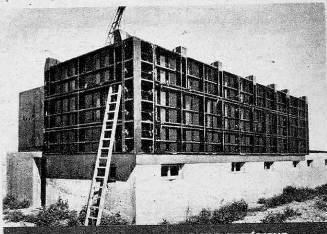
MISE EN PLACE D'UN COFFRAGE EXTÉRIEUR
