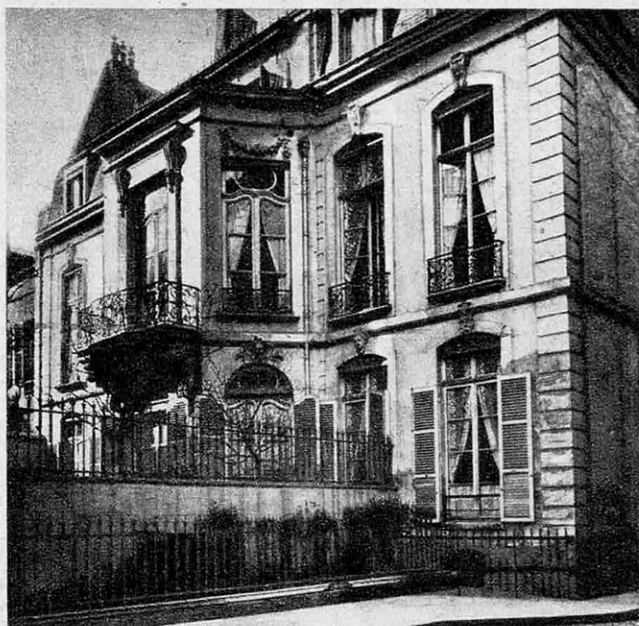
● Hôtel de Choiseul à Paris (XVIII e siècle). La décoration extérieure est très sobre. Le comble est à la Mansard et le salon avance sur le jardin.
