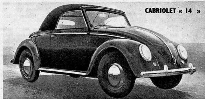
suspens. arr. à essieu oscillant, levier longit., barres de torsion lat., amort. à double effet. Frein à pied méc. ou hydrauliques, frein à main méc. sur les 4 roues. Direction à segment et écrou. Pneus 4,50 x 16, 5,00 x 16. Réservoir d'essence 42,5 litres.
