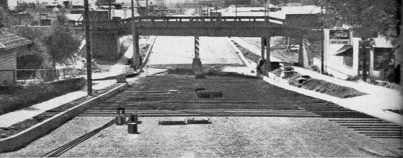
Une route qui fait fondre la neige : un rêve qui devient une réalité à Klamath Falls (Oregon). Des tubes de fer, étendus en nappes sous le revêtement de la chaussée, seront chauffés l'hiver par des sources naturelles.
