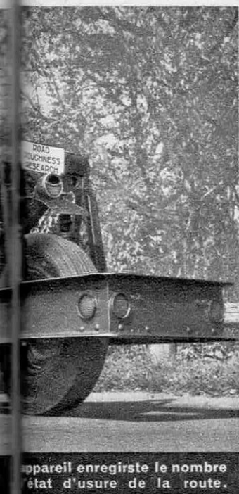
Ce vérin qu'on peut charger à volonté concentre en un point du sol une charge importante, afin de mesurer la résistance à l'écrasement des revêtements non rigides.
