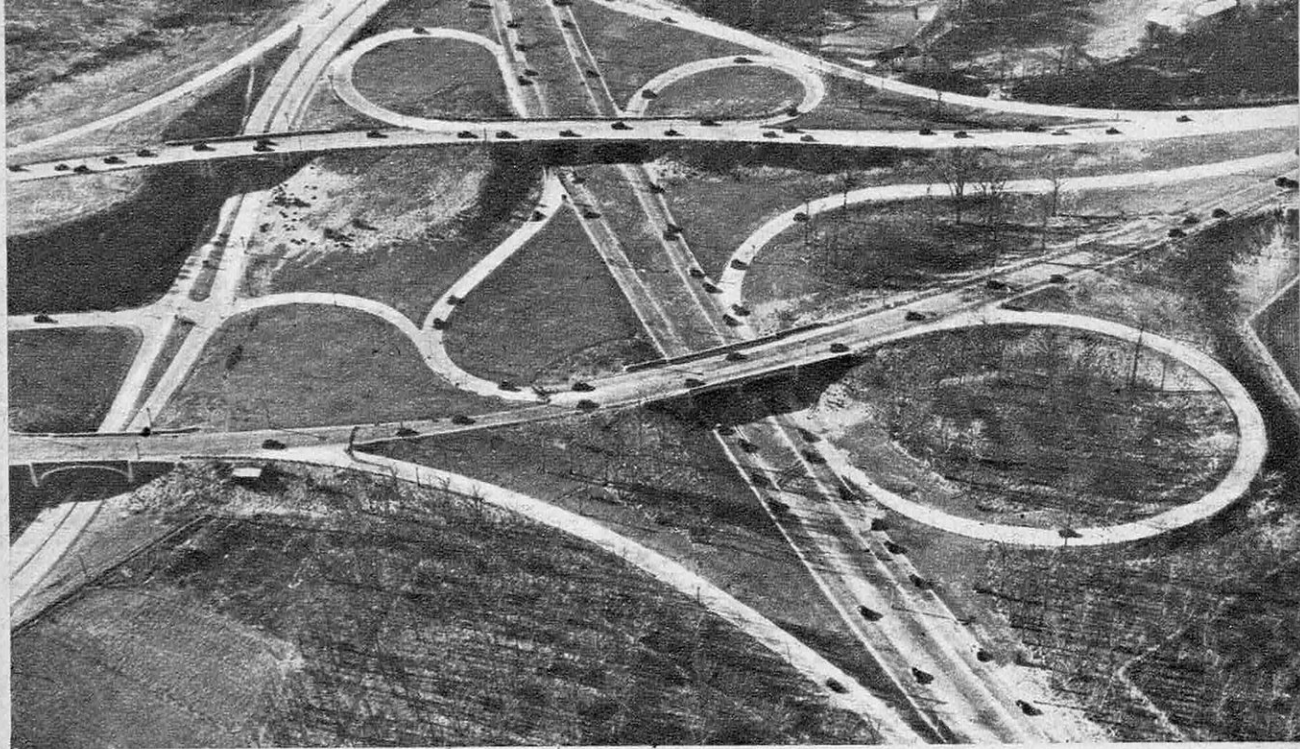
Ce curieux enchevêtrement de voies principales et de courbes de raccordement marque l'intersection des grandes artères venant du centre et de la ceinture de la ville à Long-Island, au voisinage de New-York City.
