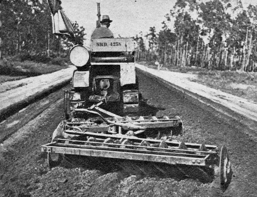
Sur une route de la Floride du Sud, ce tracteur retourne le sol et y mélange au moyen d'une herse spéciale une émulsion de bitume et de sable.
