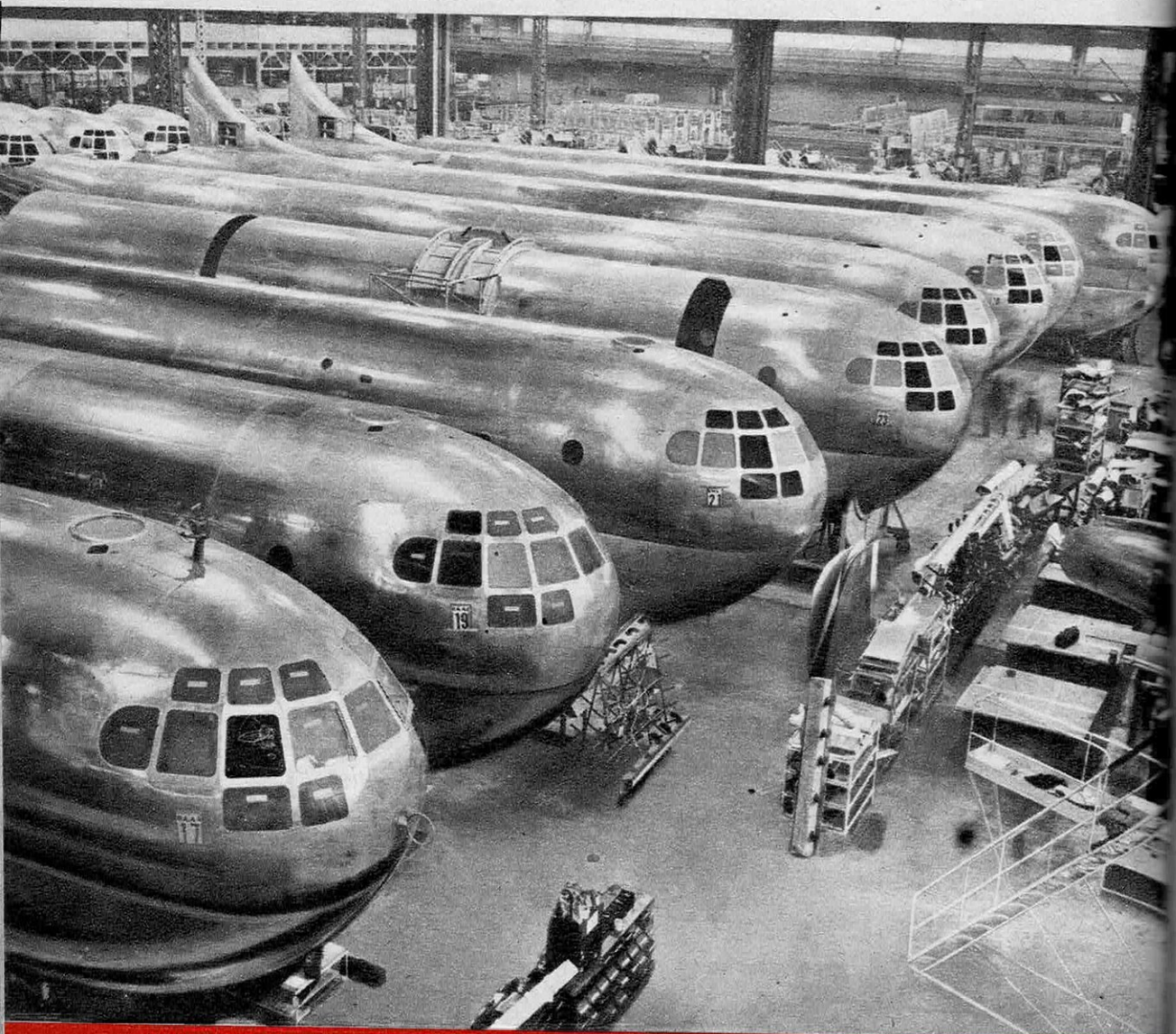
HALL DE MONTAGE DES "STRATOCRUISER" DE 70 TONNES AUX USINES BOEING DE SEATTLE.
