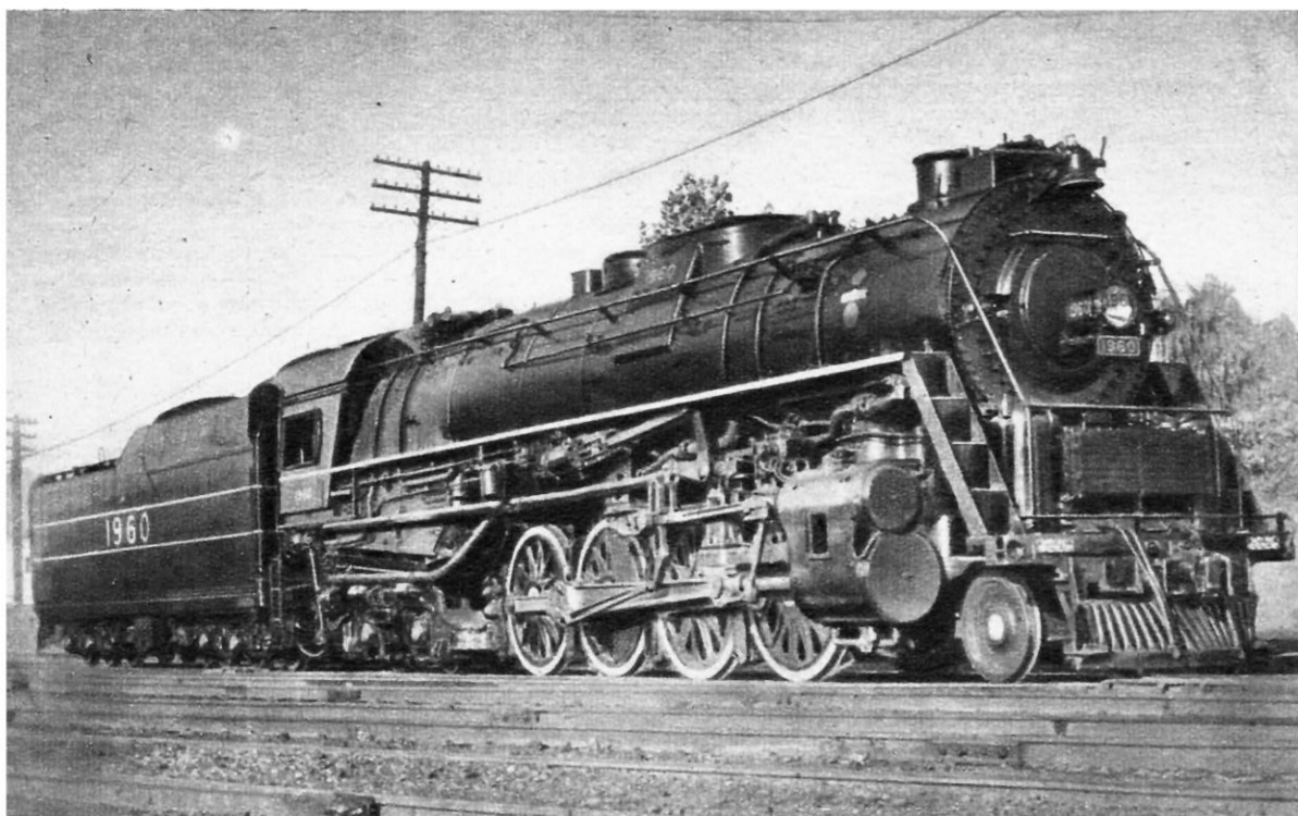
Fig. 28. LOCOMOTIVE AMÉRICAINE TYPE 142, POIDS : 204 T ; EFFORT DE TRACTION MAX. : 30 T
