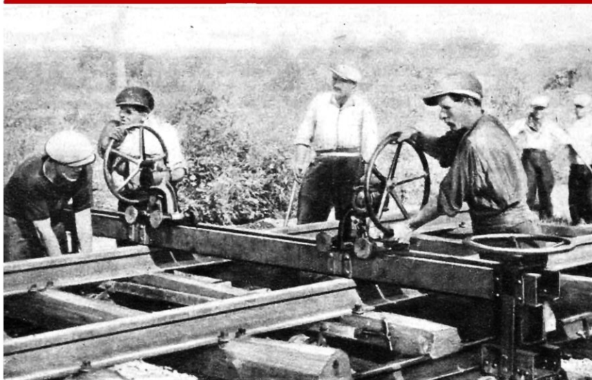
LA TRAVÉE amenée au-dessus d'une partie de voie encore en place est fixée par des agrafes à des essieux de roulement.
