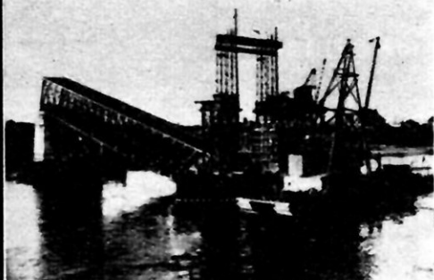
Relevage du pont de Chalampé sur le Rhin
