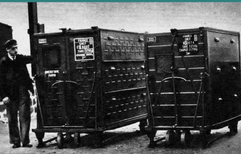
Fig. 108. CES CADRES REPOSENT SUR DES PATINS D'ACIER LORSQUE LES DISPOSITIFS DE ROULEMENT SONT ÉCLIPSÉS
