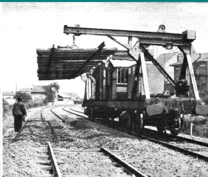
Fig. 11 et 12. DÉGARNISSEUSES SCHEUCHZER ET « SECO » : CRIBLAGE SANS DÉPOSE DE LA VOIE
