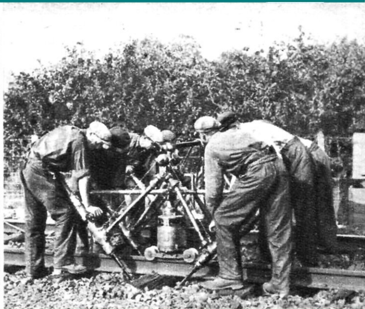
Fig. 9 et 10. APPORT DU BALLAST NEUF SUR LE CHANTIER ET BOURRAGE DE TRAVERSES
