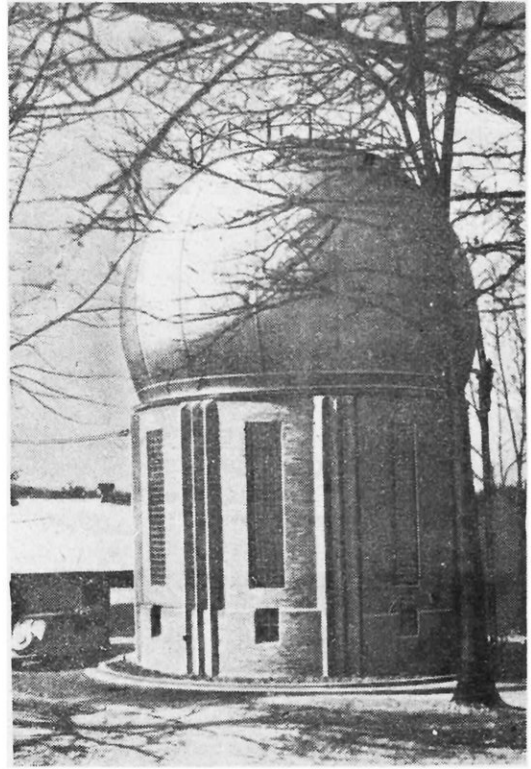
FIG. 27. — VUE EXTERIEURE DU NOUVEAU GÉNÉRATEUR POUR 5 MILLIONS DE VOLTS DE LA CARNEGIE INSTITUTION A WASHINGTON.
