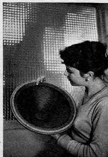
Sur ce haut-parleur haute-fidélité, une suspension par bande en peau de gant permet d'amortir les réflexions des ondes sonores.
