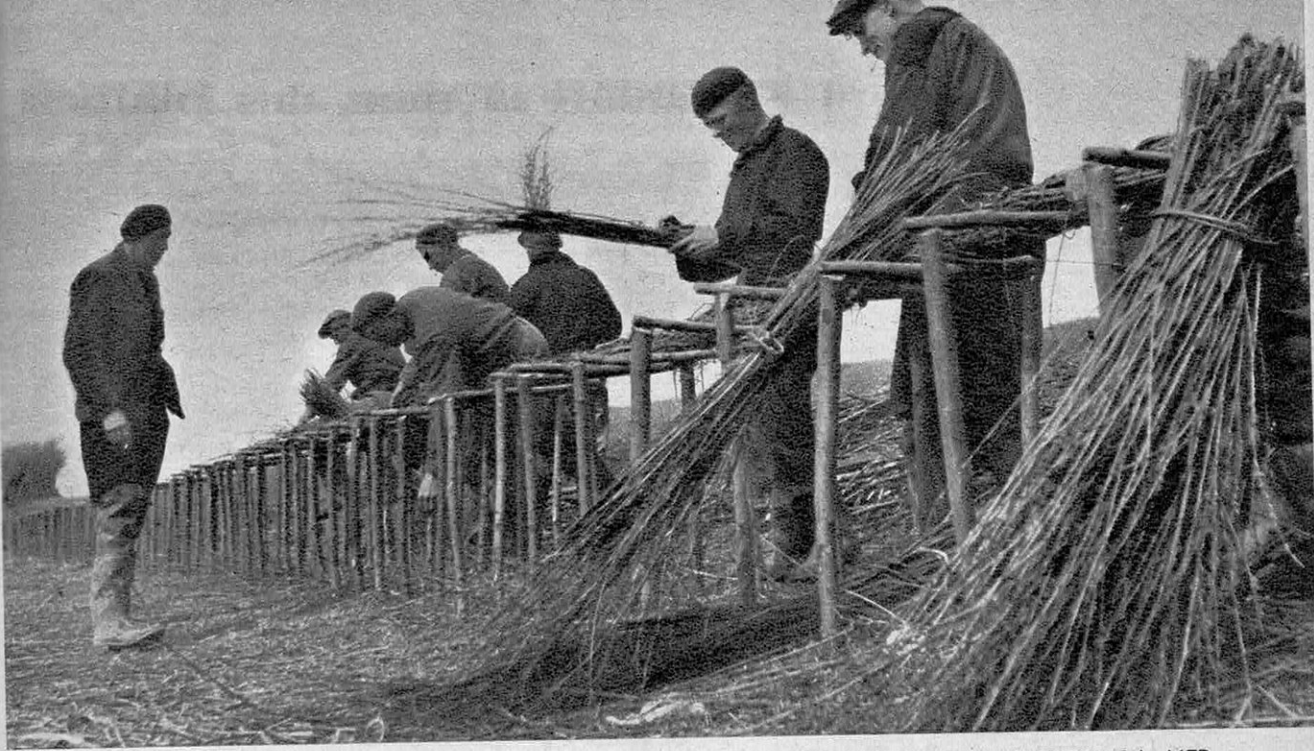
DES MATERIAUX PRIMITIFS : OSIER, SABLE, PIERRES, ARGILE SUFFISENT A ARRETER LA MER
