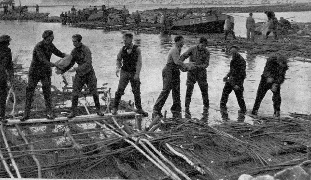
DES FASCINES LESTÉES DE PIERRES ET IMMERGÉES BRISERONT LA VIOLENCE DES COURANTS
