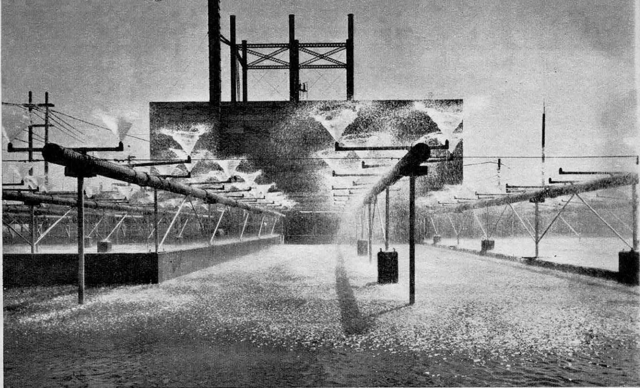
↑ **LE REFROIDISSEMENT** du premier moteur nucléaire nécessita ce lac de 80 000 hectolitres d'eau. Il fallut encore disperser l'eau chaude en pluie, pour que le refroidissement fût satisfaisant.
