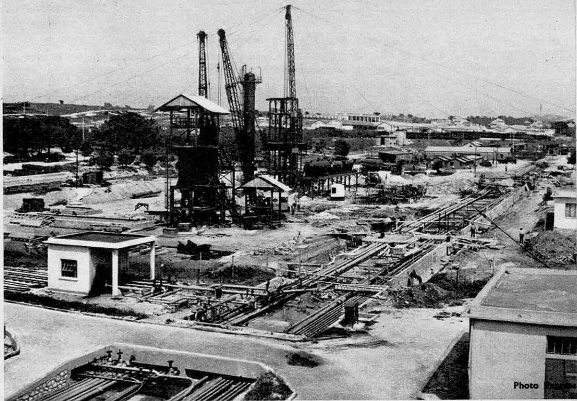
L'UNITÉ DE PLATFORMING EN CONSTRUCTION A LA RAFFINERIE SGHP DE LAVÉRA.
