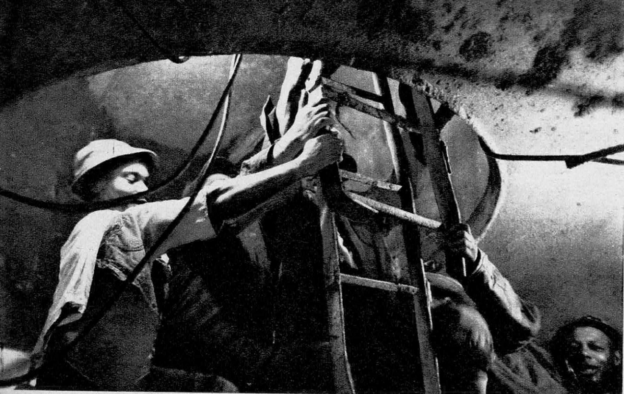
LE "TUBISTE", PAR LA CHEMINÉE PRINCIPALE, DESCEND A L'INTÉRIEUR DU CAISSON.
