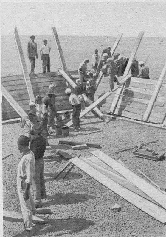
● Des kilomètres de canalisations amenaient l'eau au camp de la Barga dans un réservoir en béton dont on voit ici le premier stade de la construction.
