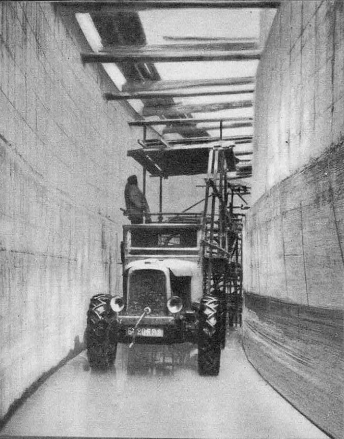
● Vue intérieure de la couronne d'étanchéité qui sera remplie d'eau et dans laquelle les 3 levées seront emboîtées.
