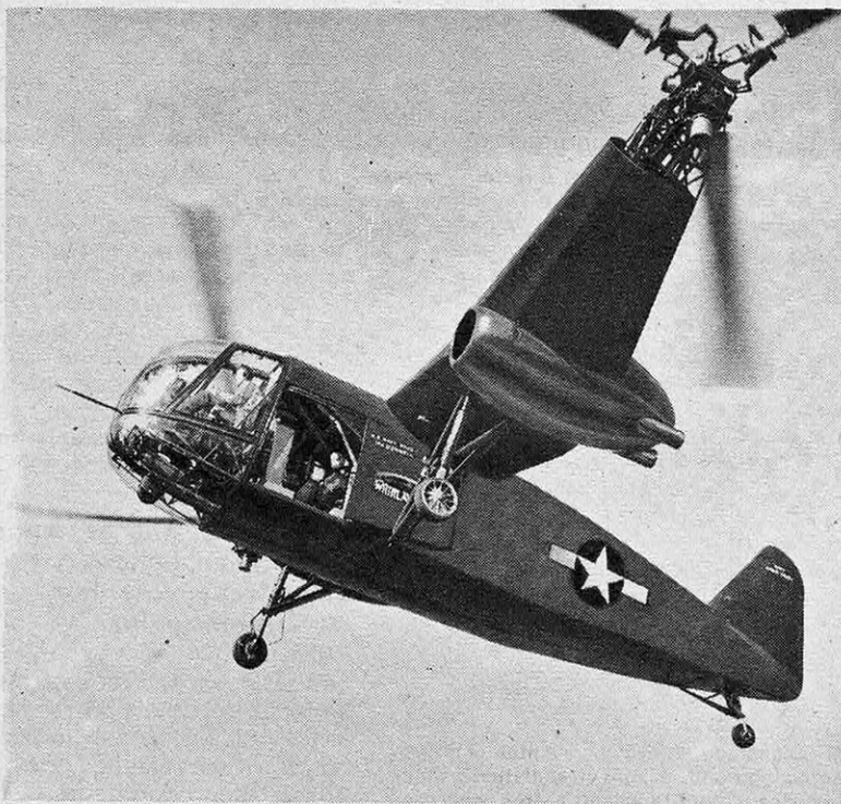
◀ L'hélicoptère MacDonnell « Whirlaway » possède deux rotors placés à l'extrémité de deux allers carénés qui forment voilure fixe. Les moteurs sont disposés dans la partie centrale des allers.
