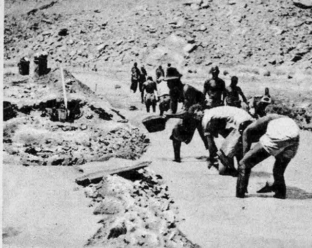
● Durant une crue de l'oued Arak, on construit un radier submersible. La piste ne sera pas longtemps coupée.
