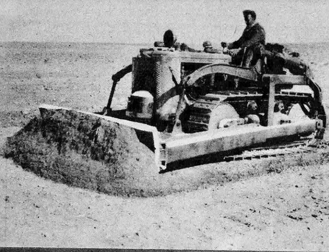
● Entretien de la piste : avec des bulldozers, on dégage les accotements de manière à éviter l'ensablement.
