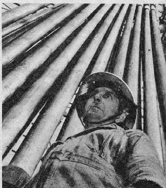
A mesure que le forage progresse, les longueurs de tube descendent les unes après les autres.
