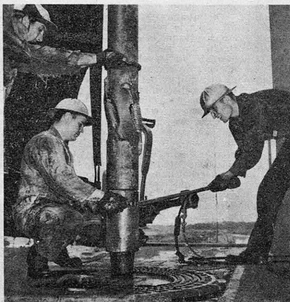
Sur le plancher d'un derrick, des spécialistes, à côté de l'orifice du puits, préparent l'appareil de forage.
