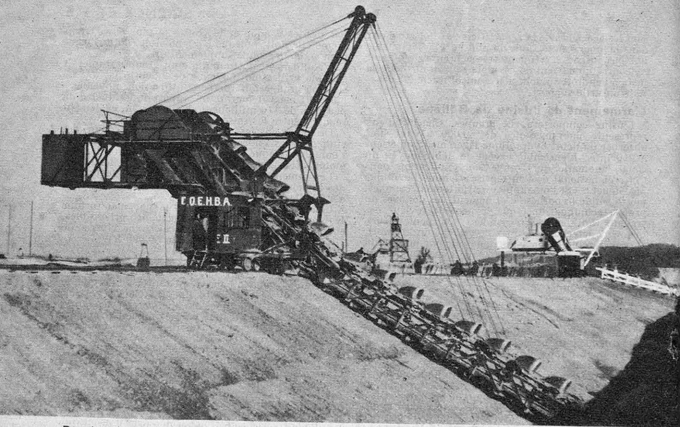
De puissantes machines, en général américaines, et de types divers, sont affectées aux travaux de terrassement du chantier de Donzère-Mondragon (50 000 000 m 3 à pelleter). On voit ici des excavateurs Coehba râclant le mélange d'eau et de terre.
