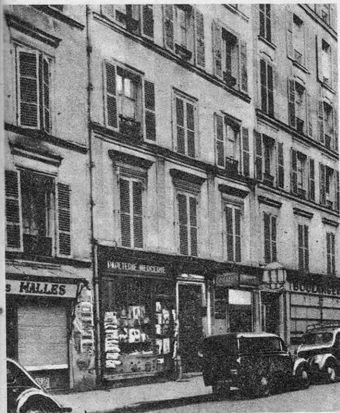
CATÉGORIE 3B 79, rue Mademoiselle, XV e . Construit il y a cent ans, vétuste. Accès et matériaux médiocres. Aucun confort à l'immeuble, ni dans les appartements (eau, gaz, électricité, pas de W.-C. privés).
