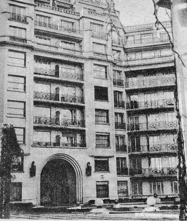
CATÉGORIE EXCEPTIONNELLE 15, rue Raynouard, XVI e . Construit en 1931. Large voûte d'accès, grand luxe : ascenseurs maîtres et service, chauffage central, vide-ordures, chute-lettres.
