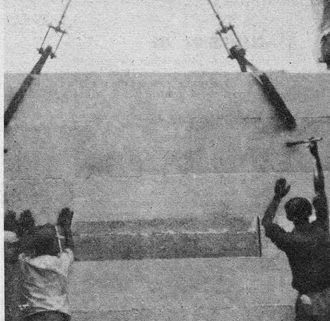
L'étanchéité du béton précontraint le rend particulièrement propre à la fabrication de réservoirs, cuves, tuyaux. Ces photographies représentent la fabrication des nouvelles cuveries Cinzano à Baillargues (Hérault). A gauche, sur la vue d'ensemble des cuves, on remarque l'extrémité des câbles de tension A droite, pose d'un panneau préfabriqué.
