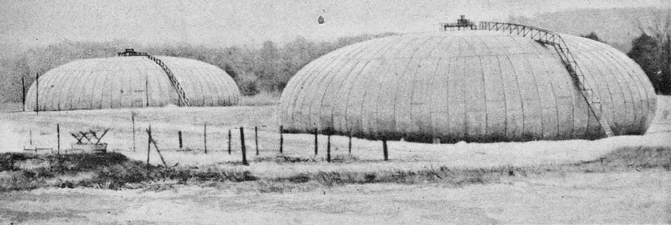
FIG. 3. — RÉSERVOIRS DE 12 750 M 3 DE LA EAST TEXAS REFINING COMPANY, A LONGVIEW (TEXAS, U. S. A.)
