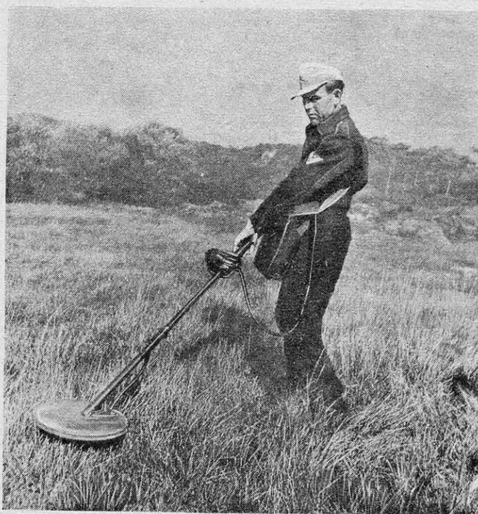
FIG. 9. — DÉMINAGE AVEC L'APPAREIL LMT
