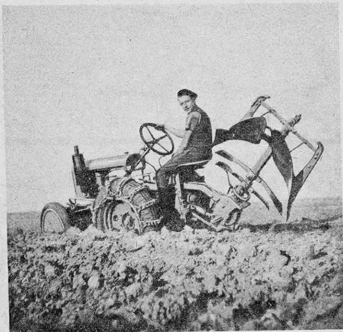
FIG. 6. — TRACTEUR BRUNEAU-ROCHER TRAINANT UNE CHARRUE BRABANT DOUBLE
