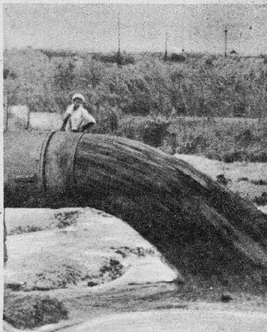
FIG. 3 ET 4. — LE COMPLEMENT DU TERRAIN MARÉCAGEUX ET LA CONSTRUCTION D'UNE PISTE D'ATTERRISSEMENT BÉTONNÉE A L'AÉROPORT D'IDLEWILD.
