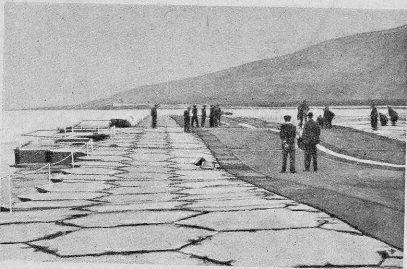
FIG. 3. — VUE DE L'AÉRODROME FLOTTANT « LILY » PENDANT SA CONSTRUCTION.
