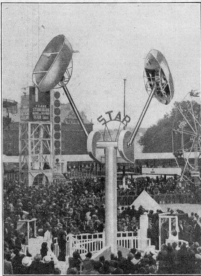
FIG. 6. — VUE D'ENSEMBLE DU « LOOPING STAR » Les deux nacelles oscillent symétriquement et s'arrêtent quelques secondes au point haut de leur course (looping arrêté).
