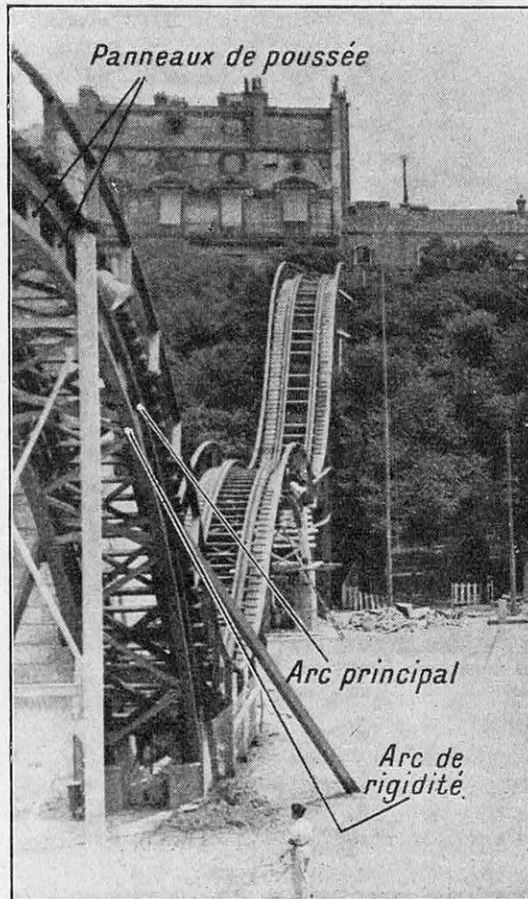
FIG. 1. — VOICI UNE PARTIE DE LA VOIE DU « SCENIC RAILWAY » MONTRANT LA NAISSANCE DE LA GRANDE ARCHE
