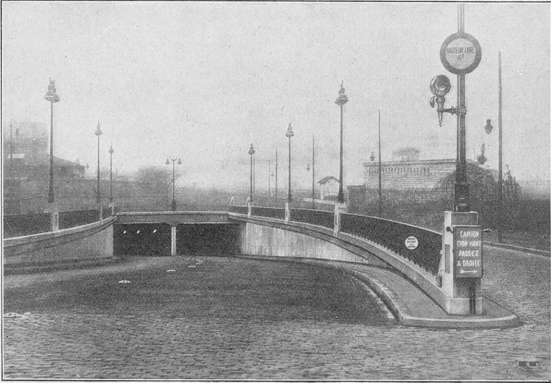
FIG. 2. — LA SIGNALISATION SONORE DÉCLENCHE ÉGALEMENT DES DISPOSITIFS « VISUELS » A L'ENTRÉE DU SOUTERRAIN DE LA PORTE DE LA VILLETTE, A PARIS
