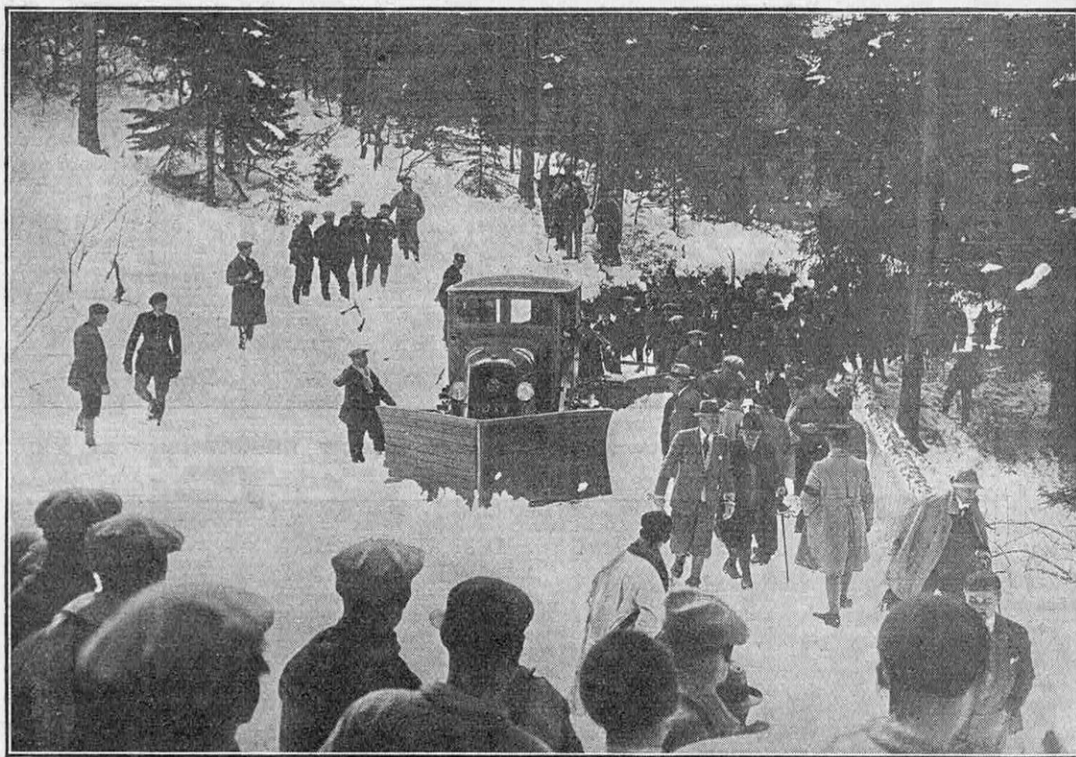
FIG. 3. — LE CHASSE-NEIGE A ÉTRAVE, EN ACTION SUR UNE ROUTE RECOUVERTE D'UNE FAIBLE ÉPAISSEUR DE NEIGE, REMPLIT PARFAITEMENT SA FONCTION
