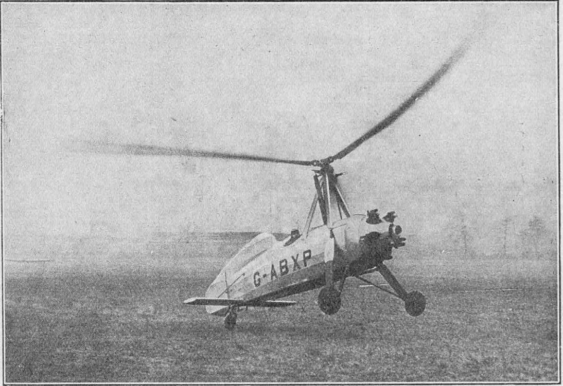
FIG. 6. — LE MODÈLE « C.-L. 10 » (LA CIERVA-LEPÈRE) Le grand plan stabilisateur a disparu. Un seul gouvernail est conservé, celui de direction.
