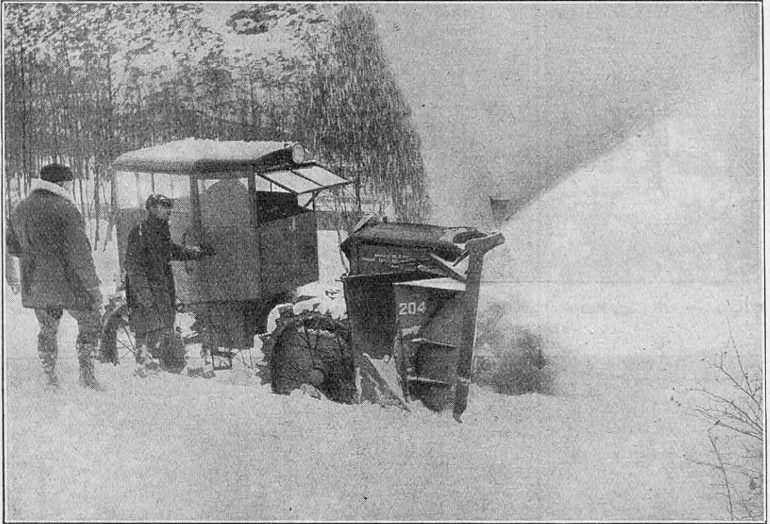
FIG. 8. — CE CHASSE-NEIGE ITALIEN, A TURBINES, REJETTE LA NEIGE A GRANDE DISTANCE DES DEUX COTÉS DE LA ROUTE. CET APPAREIL EST A LA FOIS PUISSANT ET LÉGER
