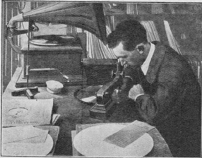
FIG. 2. — VÉRIFICATION ET CORRECTION DES PARASITES SUR UNE MATRICE (USINE GRAMOPHONE)
