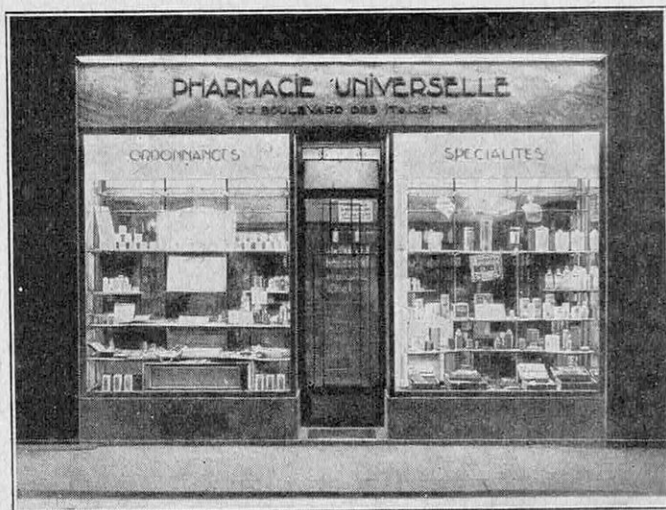
FIG. 5. — VITRINE ÉCLAIRÉE PAR DES PROJECTEURS « X-RAY » PLACÉS AU-DESSUS D'UN PLAFOND DIFFUSANT. Tous les objets de la devanture sont mis en relief, sans qu'aucune lampe soit visible de l'extérieur. La dépense de courant est bien moindre qu'avec de nombreuses lampes.
