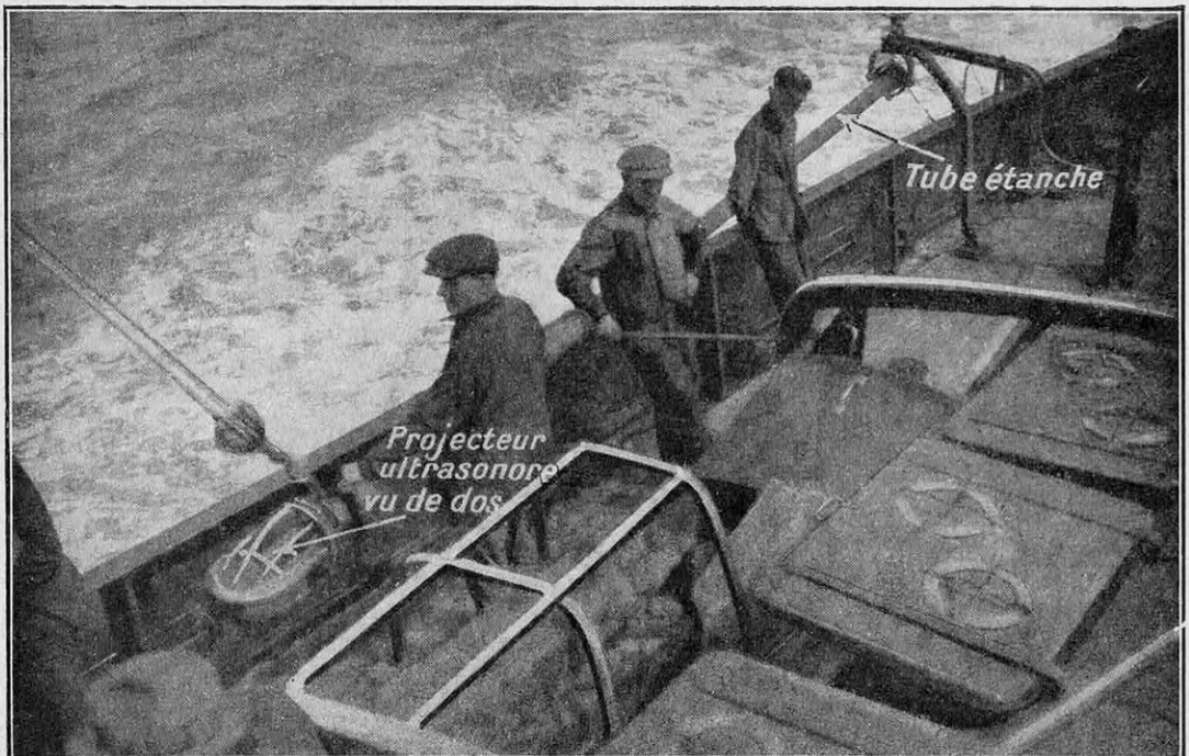
PRÉPARATIF DE MISE À L'EAU DU TUBE PORTE-PROJECTEUR A BORD DU « CHAMPION » QUI A ÉTÉ UTILISÉ POUR EFFECTUER LES EXPÉRIENCES AU PORT DE CALAIS
