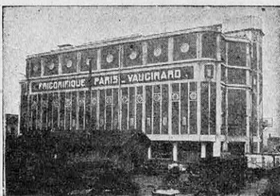
Vue générale des entrepôts frigorifiques de Paris-Vaugirard
