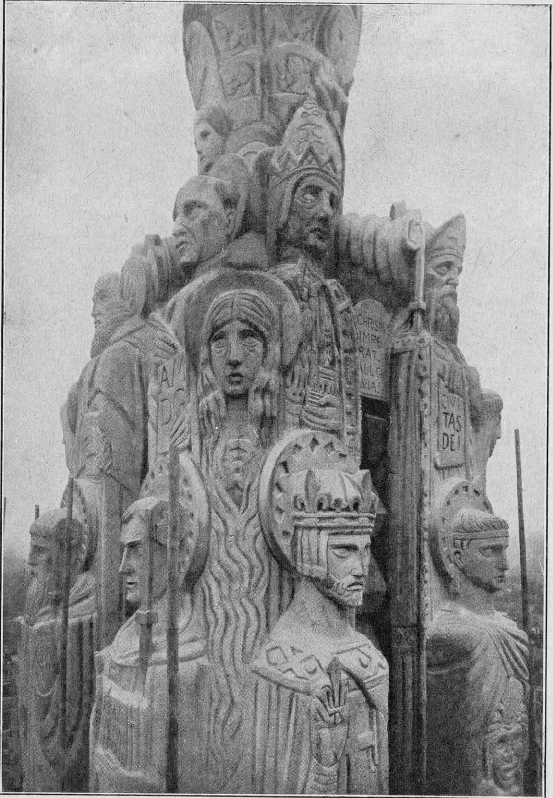
VUE D'ENSEMBLE DES STATUES SITUÉES AU SOMMET DU CLOCHER DE VILLEMOMBLE (PRÈS PARIS) ET QUI ONT ÉTÉ SCULPTÉES A FRESQUE DANS LE BÉTON ARMÉ
