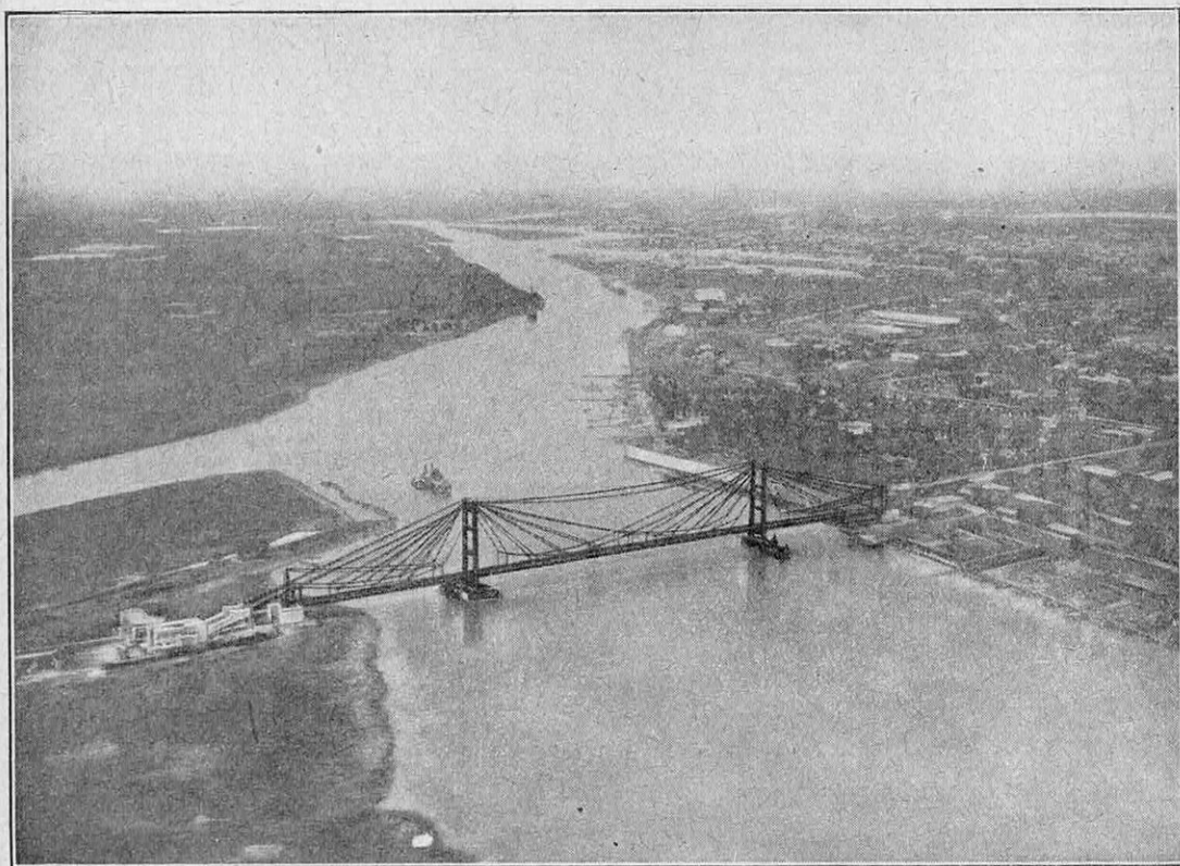
VUE PRISE EN AVION DU GRAND PONT SUR LA LAGUNE SETUBAL (RÉPUBLIQUE ARGENTINE)
