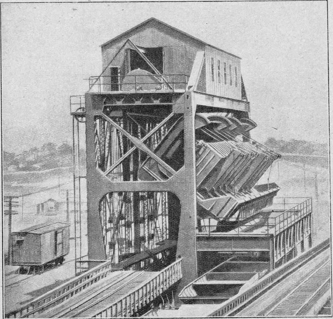
LE DÉCHARGEMENT DES WAGONS DE CHARBON PAR DES PROCÉDÉS PUREMENT MÉCANIQUES EXIGE, POUR ÊTRE RAPIDE, LA CONSTRUCTION D'ÉDIFICES COÛTEUX ET ENCOMBRANTS, TEL CE BASCULEUR QUI VIDE DEUX WAGONS À LA FOIS
