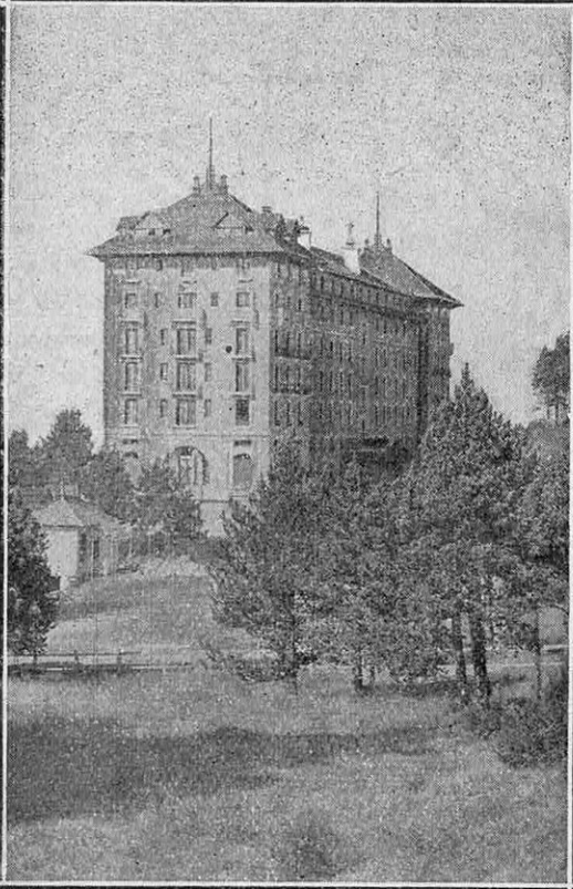
L'HOTEL DE FONT-ROMEU (PYRÉNÉES-ORIENTALES) DONT LES ORDURES MÉNAGÈRES SONT INCINÉRÉES DANS UN FOUR DE DIMENSIONS TRÈS RESTREINTES, INSTALLÉ DANS LE SOUS-SOL
