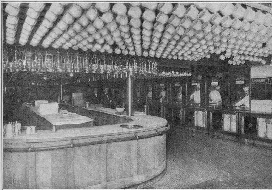
OFFICE ET GUICHETS DE SERVICE DE LA CUISINE PRINCIPALE DU « PARIS »
