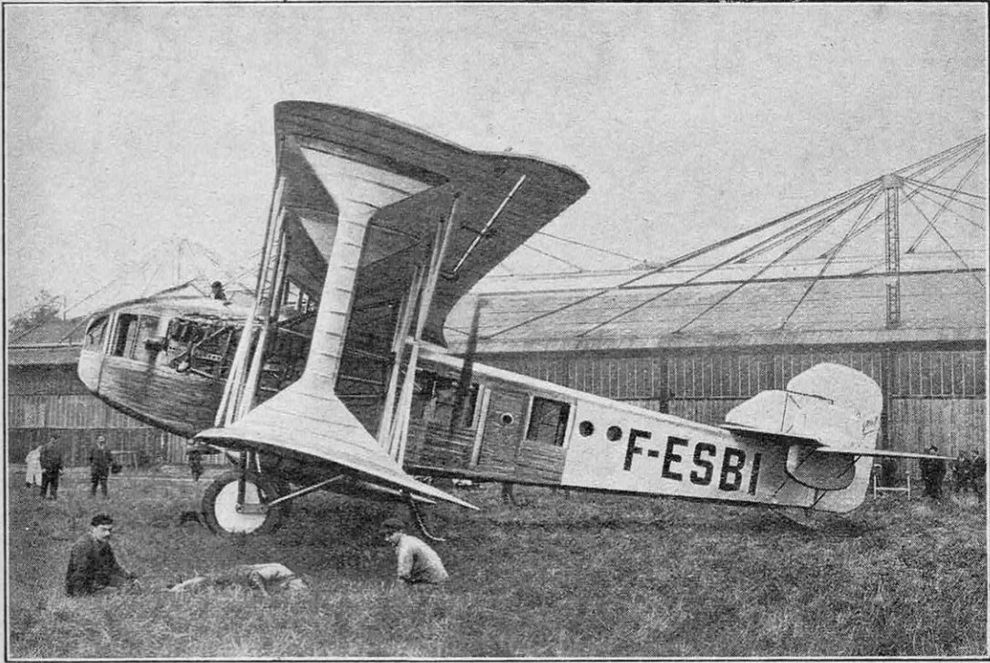
VUE LATÉRALE D'UN AVION MÉTALLIQUE BRÉGUET « LÉVIATHAN », TYPE XXII
