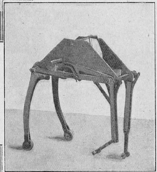
MÉCANISME INTÉRIEUR DE L'ÉLÉPHANT MARCHEUR
