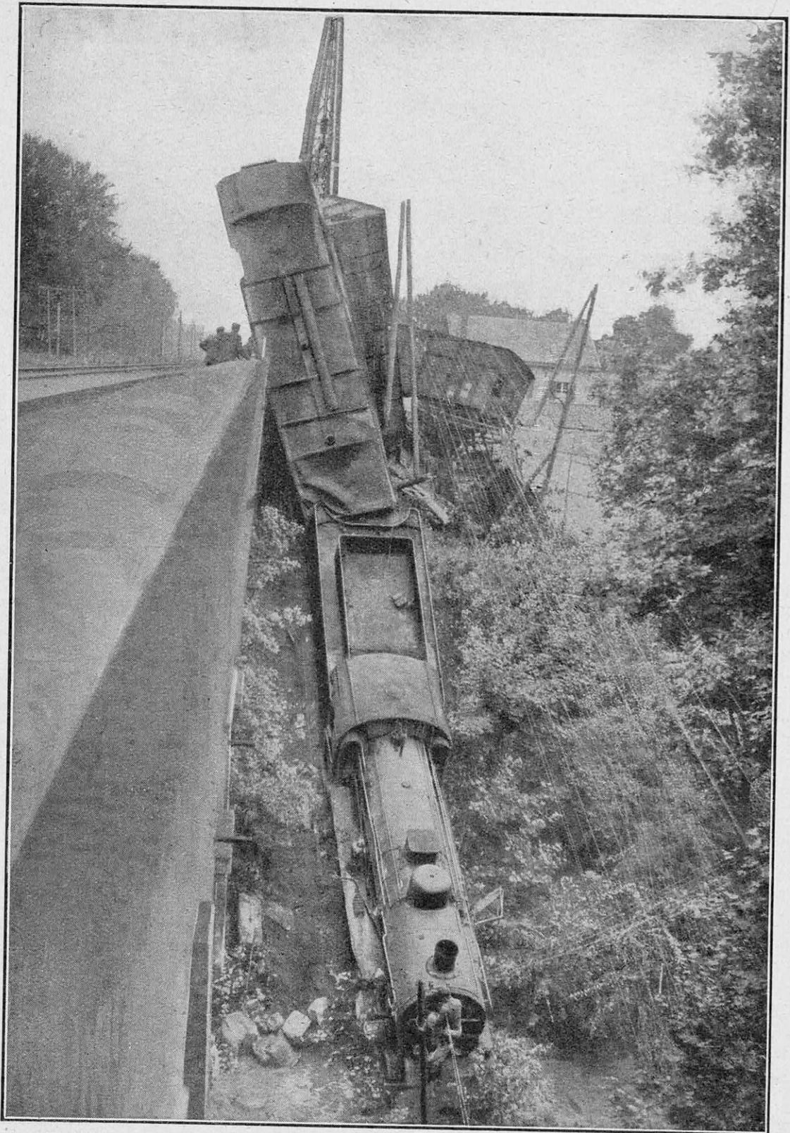
REMETTRE SUR LA VOIE CETTE MACHINE FUT, ON LE CONÇOIT, UN TRAVAIL LONG ET PÉNIBLE Accident survenu le 31 août 1924, au viaduc de la Canardière, près Chantilly (Oise).
