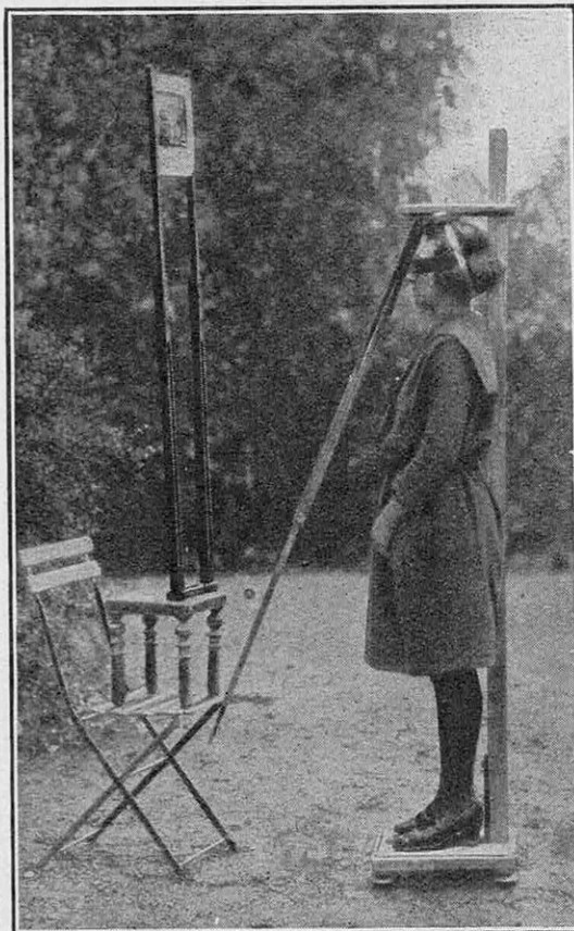
APPAREIL DESTINÉ A CONTROLER LA DIRECTION DES RAYONS VISUELS CAPABLES DE PASSER PAR-DESSUS OU PAR-DESSOUS LE BANDEAU
