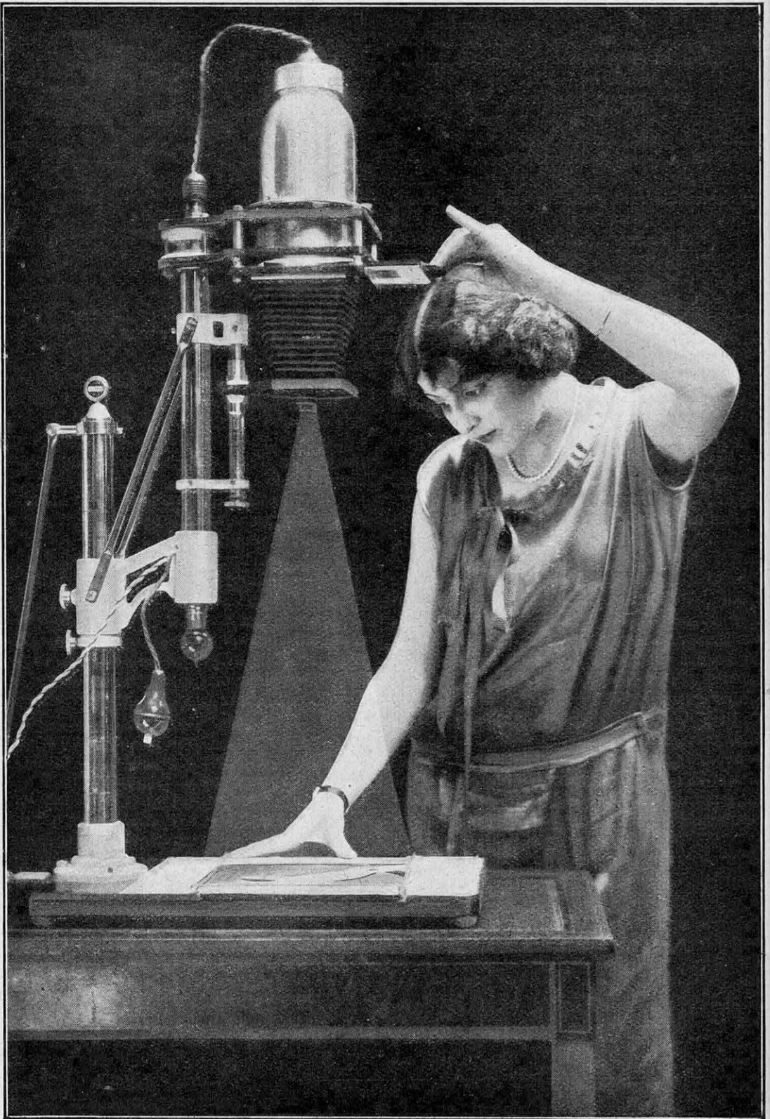
CET APPAREIL MET L'AGRANDISSEMENT A LA PORTÉE DE TOUS LES AMATEURS Il permet des agrandissements aussi nets que les épreuves obtenues directement des clichés.
