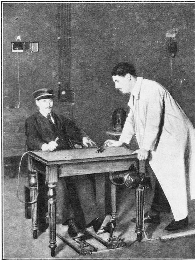
FIG. 3. — ÉPREUVE D'ATTENTION DIFFUSÉE ET MESURE DE L'« ÉMOTIVITÉ » DU CANDIDAT Assis devant une table, chaque pied sur une pédale, ayant dans la main droite un petit appareil lui permettant d'établir un contact électrique, le candidat a, devant lui, un écran entouré de lampes de diverses couleurs. Un timbre de bois et un timbre métallique complètent le dispositif. A chaque signal, provenant de la combinaison des lampes et des timbres, correspond une manœuvre (voir tableau, page 216). Toutes les « réponses » sont enregistrées. En outre, deux doigts de la main gauche sont plongés dans deux éprouvettes contenant de l'eau salée et intercalées dans un circuit électrique, comprenant un galvanomètre. Le fort clakson situé sous la table donne au candidat des commotions psychiques qui se traduisent par des déviations du galvanomètre. En A, on voit l'ouverture à travers laquelle on projette un film sur l'écran pour distraire l'attention du candidat.
