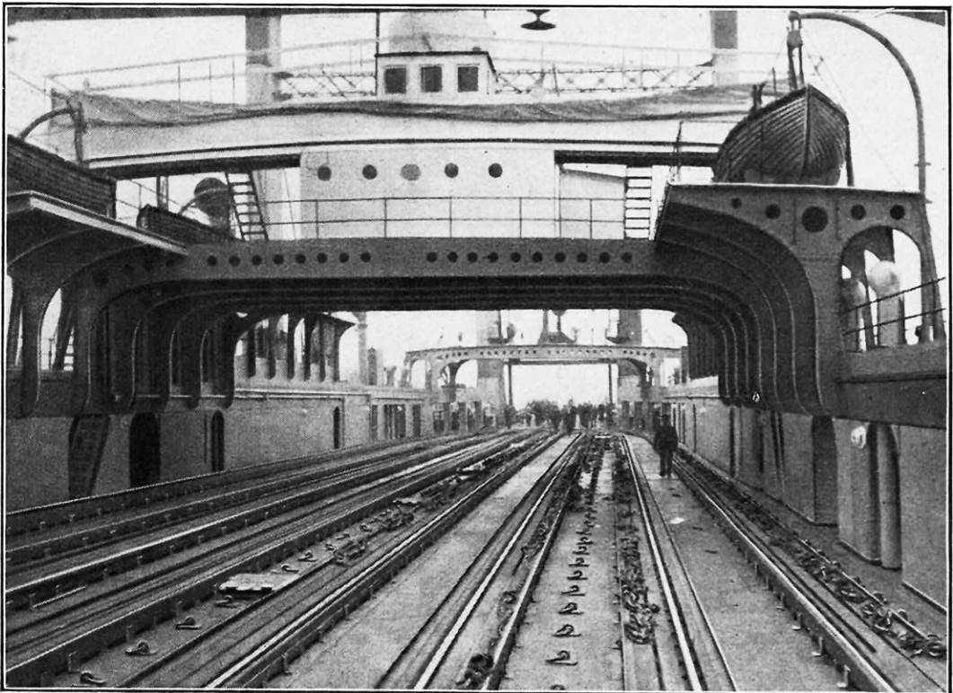
PHOTOGRAPHIE DE L'INTÉRIER D'UN FERRY-BOAT, AMARRÉ A L'APPONTEMENT ET RELIÉ AU RÉSEAU FERRÉ CONTINENTAL PAR LA PASSERELLE
