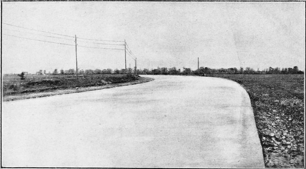
A MIRAMAS (BOUCHES-DU-RHONE), LES TRÈS GRANDS RAYONS ONT PERMIS DE NE RELEVER QUE TRÈS PEU LES VIRAGES
