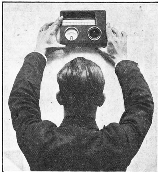
FIG. 4. — MESURE D'ÉCLAIREMENT SUR UN MUR (APPAREIL VERTICAL)
