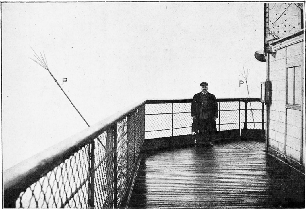
PARATONNERRES A AIGRETTES INSTALLÉS AU SOMMET DE LA TOUR EIFFEL Les aigrettes sont fixés à l'extrémité des perches P, qui ont une inclinaison de 45 degrés.
