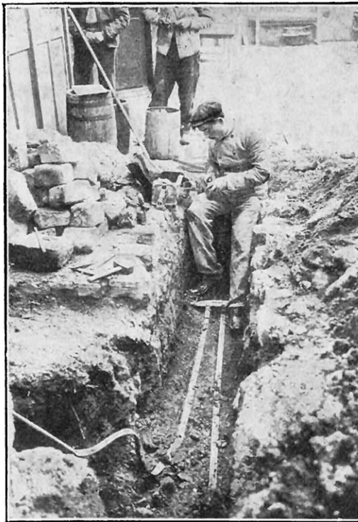
INSTALLATION D'UNE PRISE DE TERRE A RUBAN
