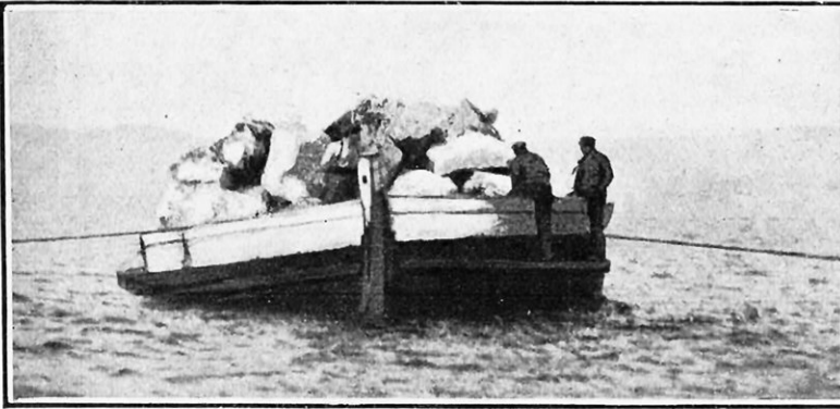
FIG. 5. — IMMERSION DE GROS BLOCS DE ROCHERS POUR LA CONSTRUCTION D'UNE DIGUE
