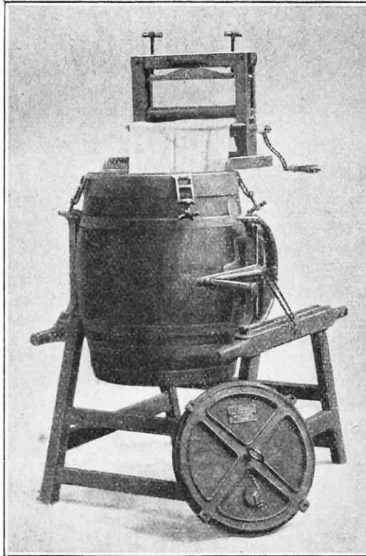
FIG. 1. — MACHINE A LAVER DU SYSTEME A OSCILLATION : LAVEUSE « SAMO »
