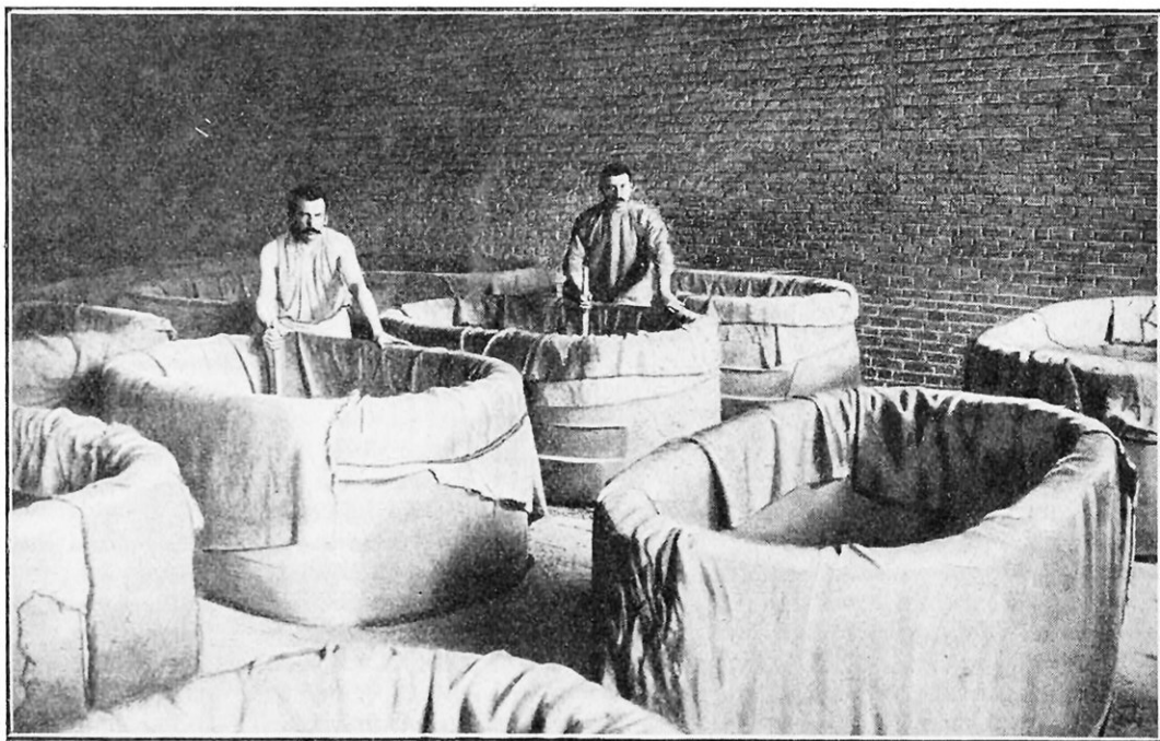
LA CONFECTION DES « POTS » SERVANT DE CREUSETS DANS LA FABRICATION DES GLACES
