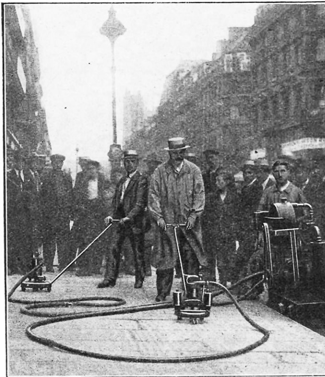
BOUCHARDAGE DES DALLES D'UN TROTTOIR A L'AIDE D'APPAREILS A AIR COMPRIMÉ, ACTIONNÉS PAR UN MOTEUR A PÉTROLE MONTÉ SUR UN PETIT CHARIOT
