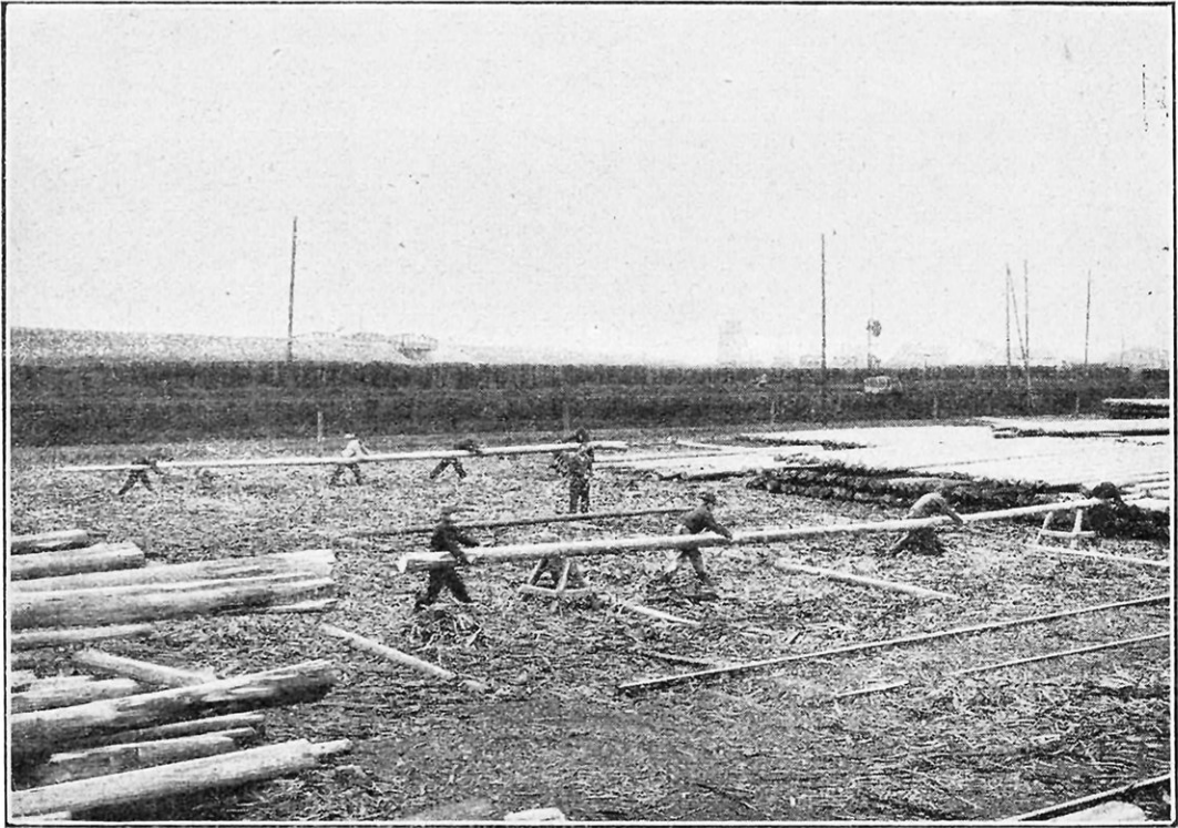
VUE PARTIELLE D'UN CHANTIER DE SÉCHAGE A AIR LIBRE DE LA SOCIÉTÉ FRANCO-BELGE D'IMPRÉGNATION DES BOIS, A BRÉBÏÈRES (PAS-DE-CALAIS)
