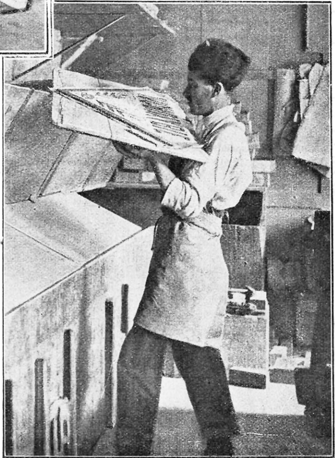
LES CUBES, ASSEMBLÉS ET COLLÉS SUR UNE FEUILLE DE PAPIER ÉPAIS, SONT MIS A L'ÉTUVE POUR LE SÉCHAGE
