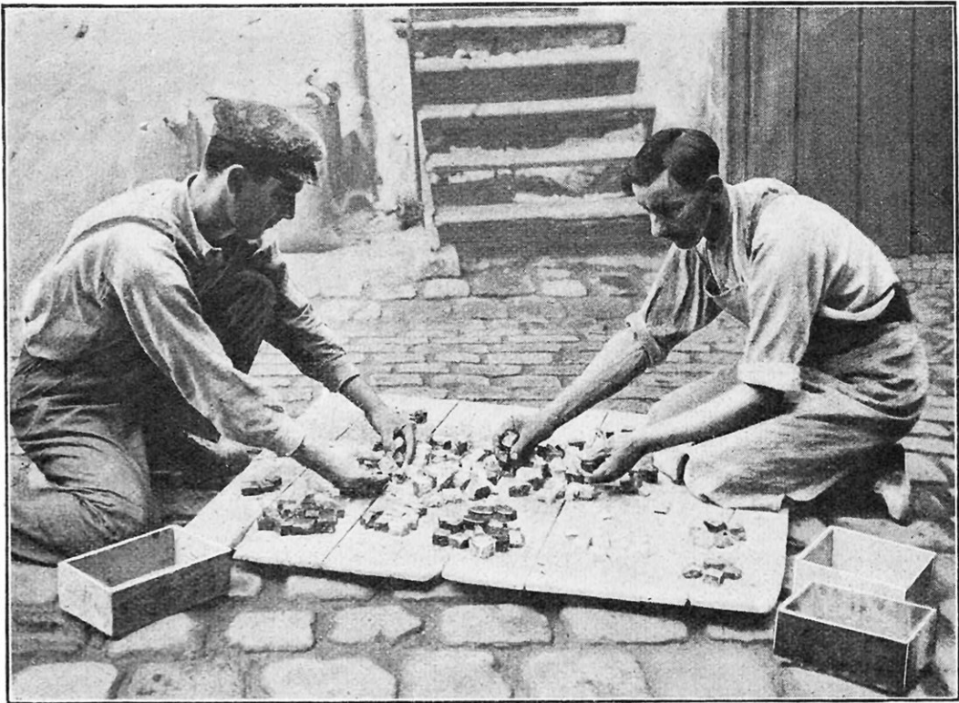
LE TRIAGE DES CUBES PAR NUANCES AU COMMENCEMENT DU TRAVAIL.
