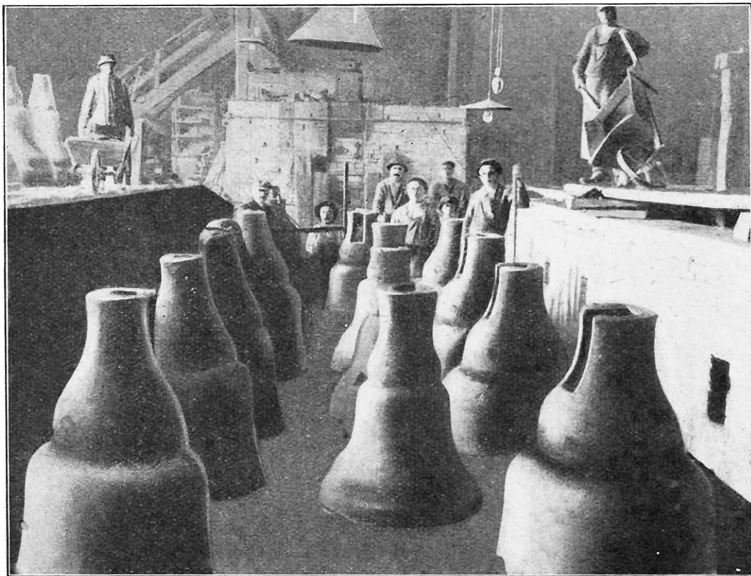
OPÉRATION DITE DE L' « ENTERRAGE », EN VUE D'UNE COULÉE PROCHAINE
