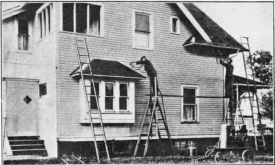
VILLA PEINTE EXTÉRIEUREMENT A L'AIDE DU PISTOLET A AIR COMPRIMÉ L'air nécessaire à la projection est comprimé sur place au moyen d'un groupe compresseur mobile.
