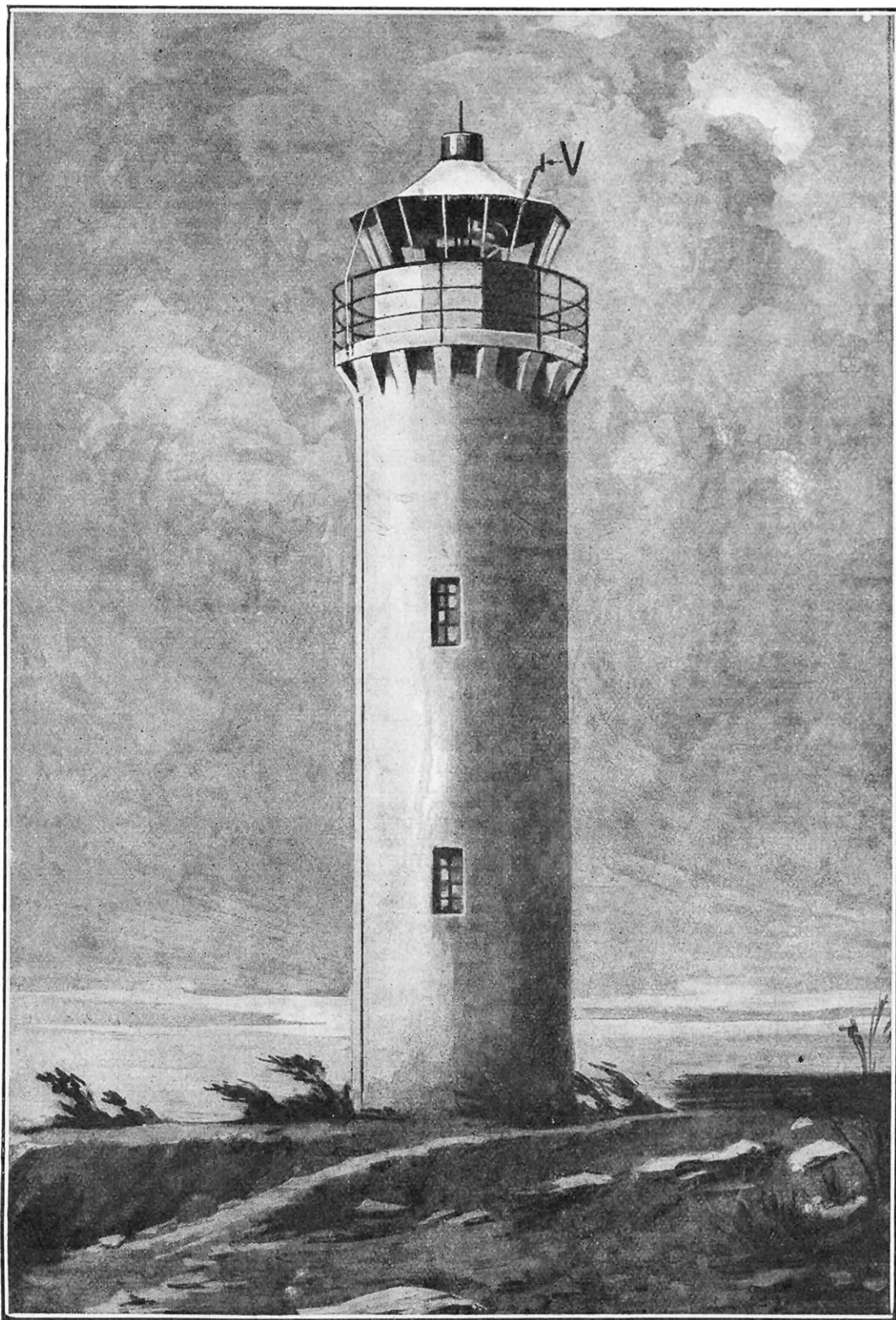
LE PHARE SANS GARDIENS DE LÄGERHOLMEN (SUÈDE). PORTÉE LUMINEUSE : 17 MILES L'allumage et l'extinction se font automatiquement au moyen de la « Valve solaire A. G. A. » (V)
