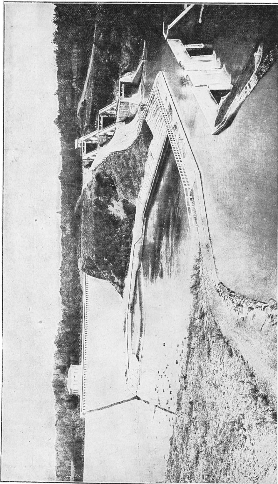
BARRAGE ÉLEVÉ A DELTA POUR ASSURER PENDANT L'ÉTÉ L'ALIMENTATION DE LA BRANCHE ORIENTALE DU CANAL ÉRIÉ. Ce barrage, entièrement en béton armé, mesure une trentaine de mètres de hauteur et retient environ 56.635.000 mètres cubes d'eau dans un bassin naturel. Il est alimenté par les eaux de la rivière Molarok. On voit, à droite, les vannes de décharge du réservoir dans le canal et le pont qui forme ce dernier au-dessus de la Moharok.
