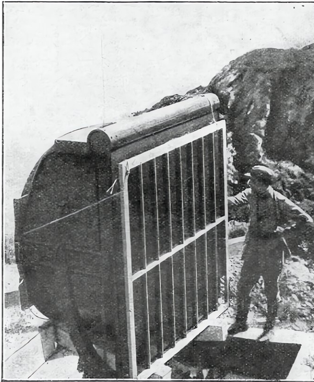
PROJECTEUR DE MARINE UTILISÉ POUR DES EXPÉRIENCES DE SIGNALISATION PAR RAYONS INFRA-ROUGES
