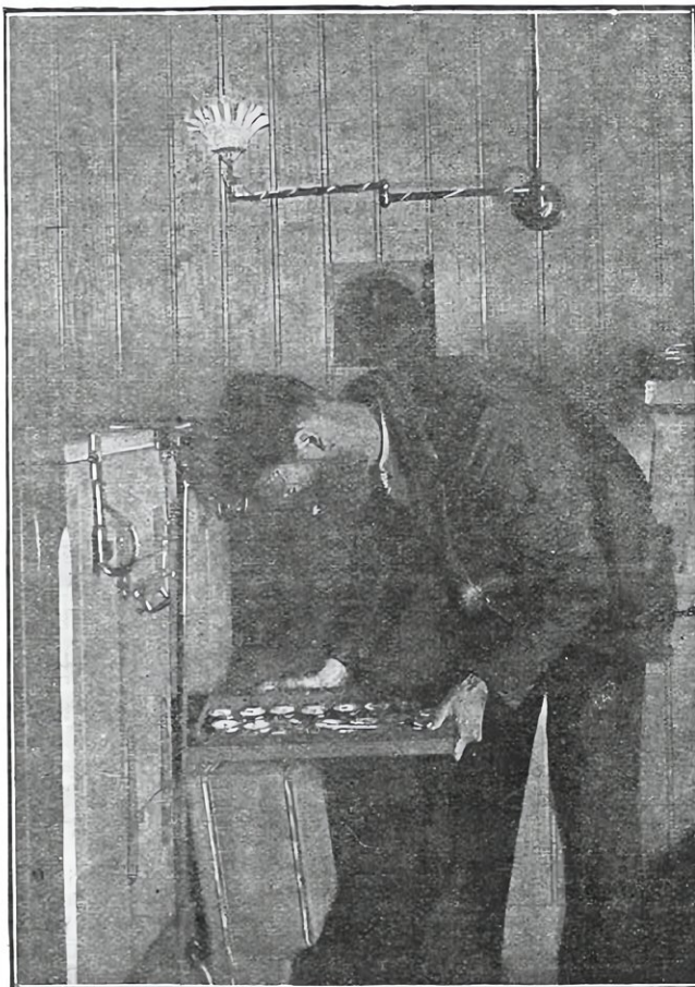
MISE DES MONTRES DANS LA GLACIÈRE, A L'OBSERVATOIRE CHRONOMÉTRIQUE
