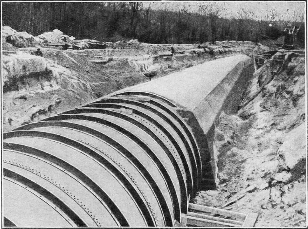
VUE D'UNE DES CANALISATIONS D'EAU PENDANT SA CONSTRUCTION
