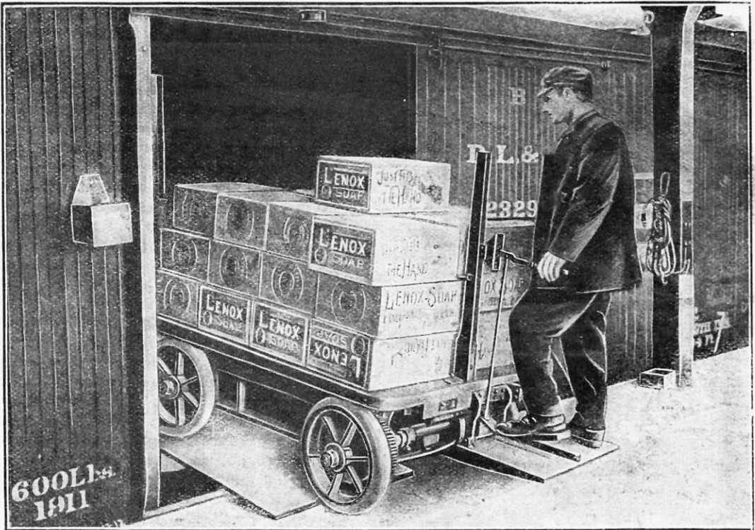
CHARIOT ÉLECTRIQUE PÉNÉTRANT DANS UN WAGON AVEC SON CHARGEMENT
